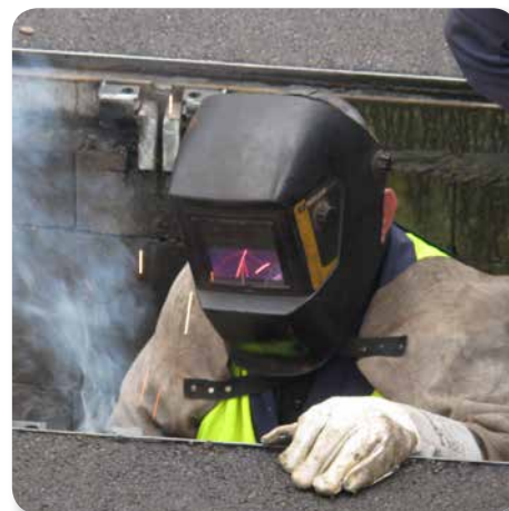
Sonderbau Mitarbeiter bei einer Deckelsanierung vor Ort
