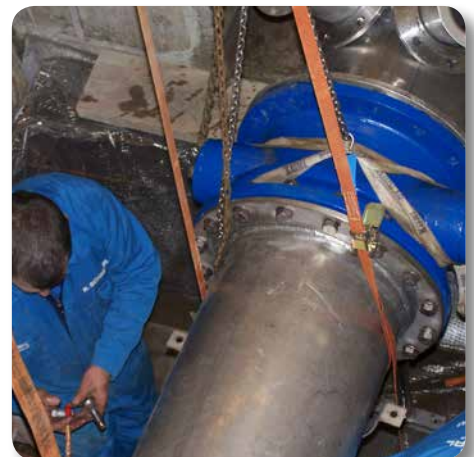
Montage einer großdimensionierten Pumpendruckleitung vor Ort
